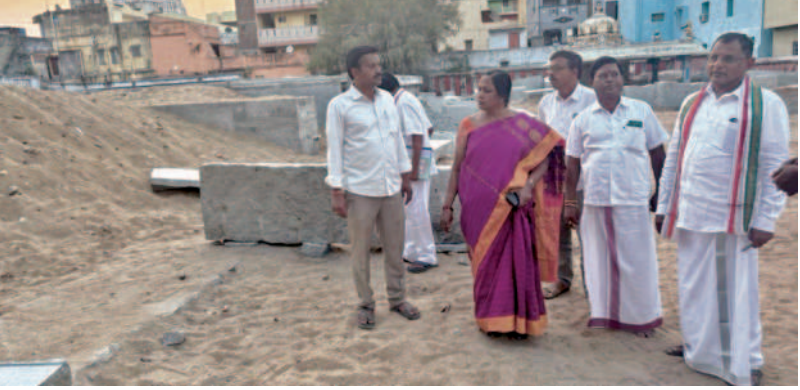
వరదరాజస్వామి ఆలయ పనులను పరిశీలిస్తున్న ఇ.ఇ.ఎన్.వి.నాగేశ్వరరావు
